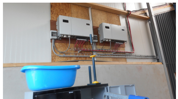
Omvormers op een brandbare ondergrond bevestigd. Foto: SOBH.
